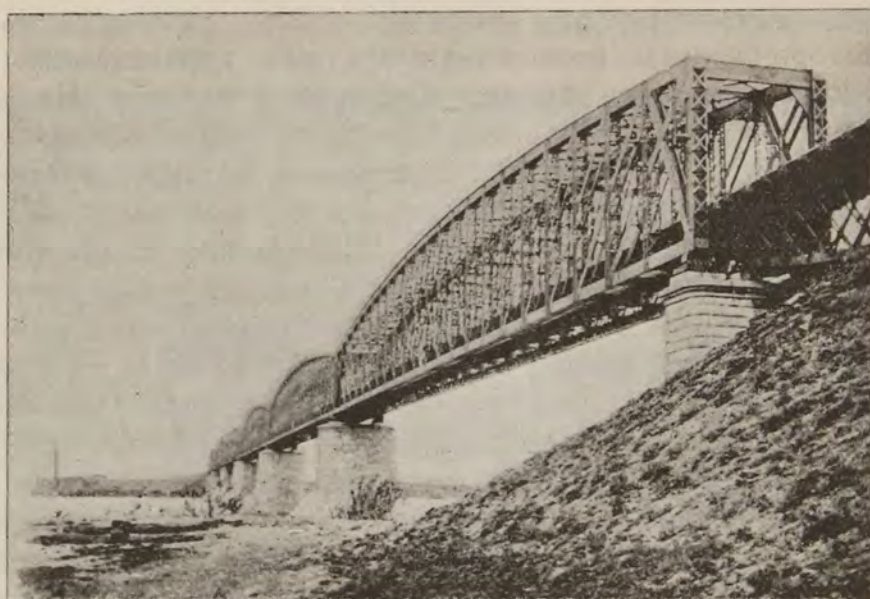
МОСТЪ ЧЕРЕЗЪ р. ИРТЫШЪ,—гор. ОМСКЪ.
