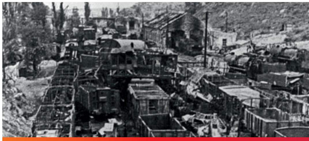
Оборона Севастополя и битва за Крым (30 октября 1941 г. — 4 июля 1942 г.). Железнодорожная станция близ Севастополя, разрушенная немецкой авиацией. РИА Новости / М. Редькин
