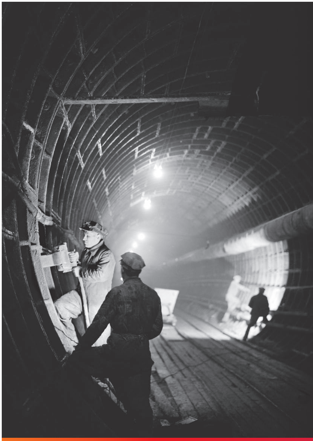
Строительство метро Арбатско-Покровской линии в Москве. 1944 г. РИА Новости / Анатолий Гаранин
