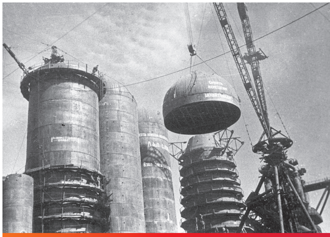
Магнитогорский Металлургический комбинат. Строительство доменной печи № 6, самой большой в Европе. 1943 г. РИА Новости / И. Шагин
