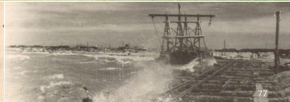
Забивка наклонных свай деревянным копром на опоре разводного пролета.
