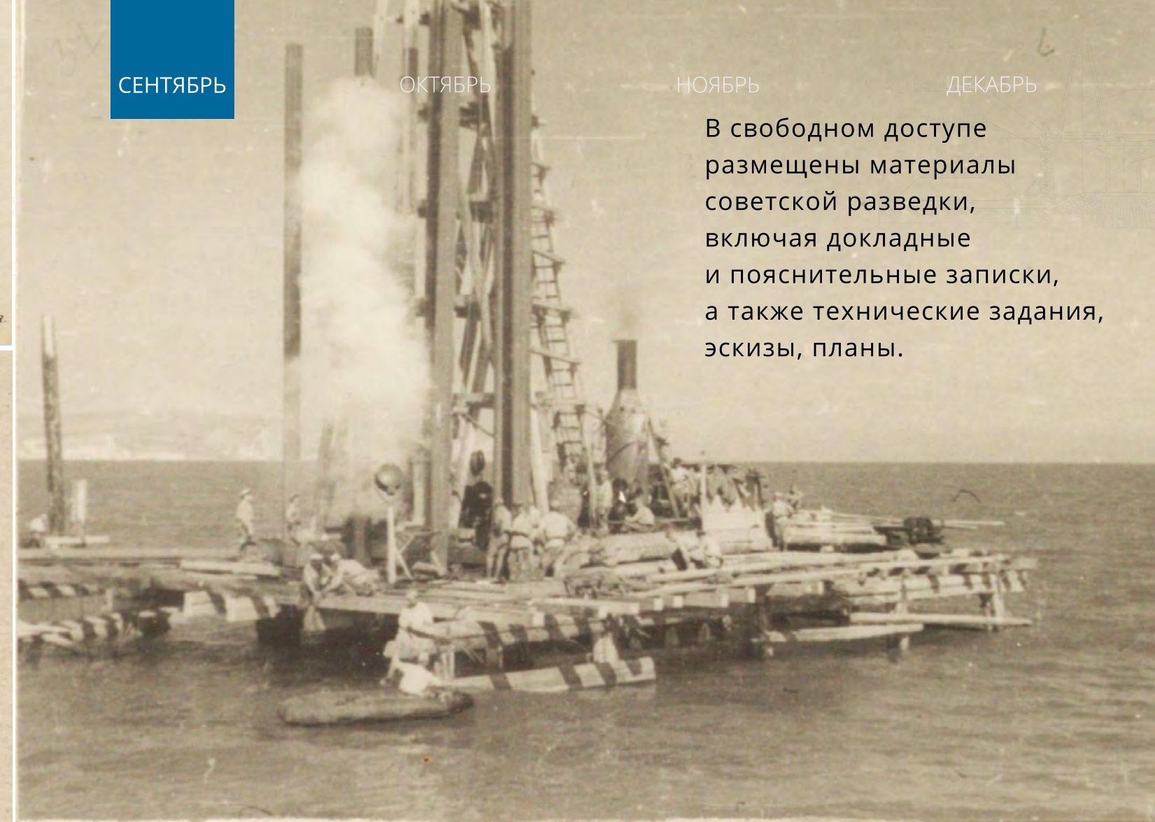
Забивка наклонных свай деревянным копром на опоре разводного пролета.
