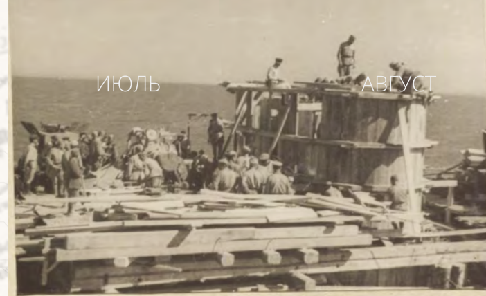
Бетонные работы на опоре № 126 разводного пролета.
