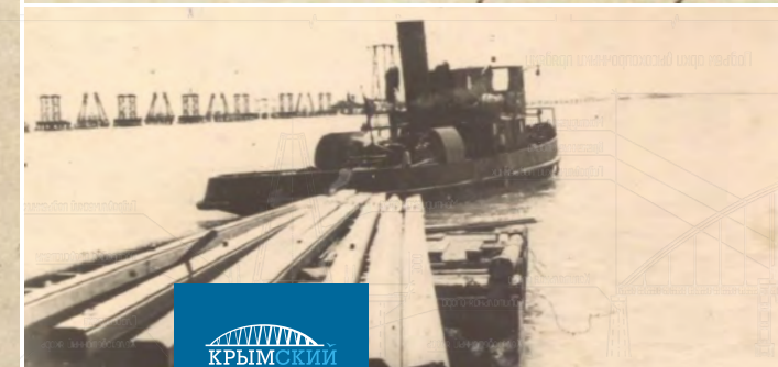
Забивка наклонных свай деревянным копром на опоре разводного пролета.
