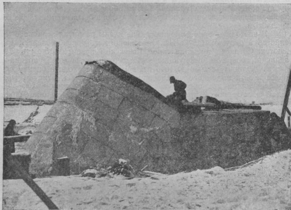
Рис. 10. Бык Иртышского моста во время ледохода.
