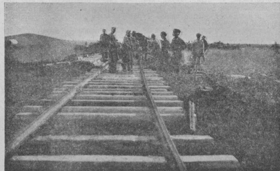
Рис. 11. Укладка пути на 13 км южного участка.
