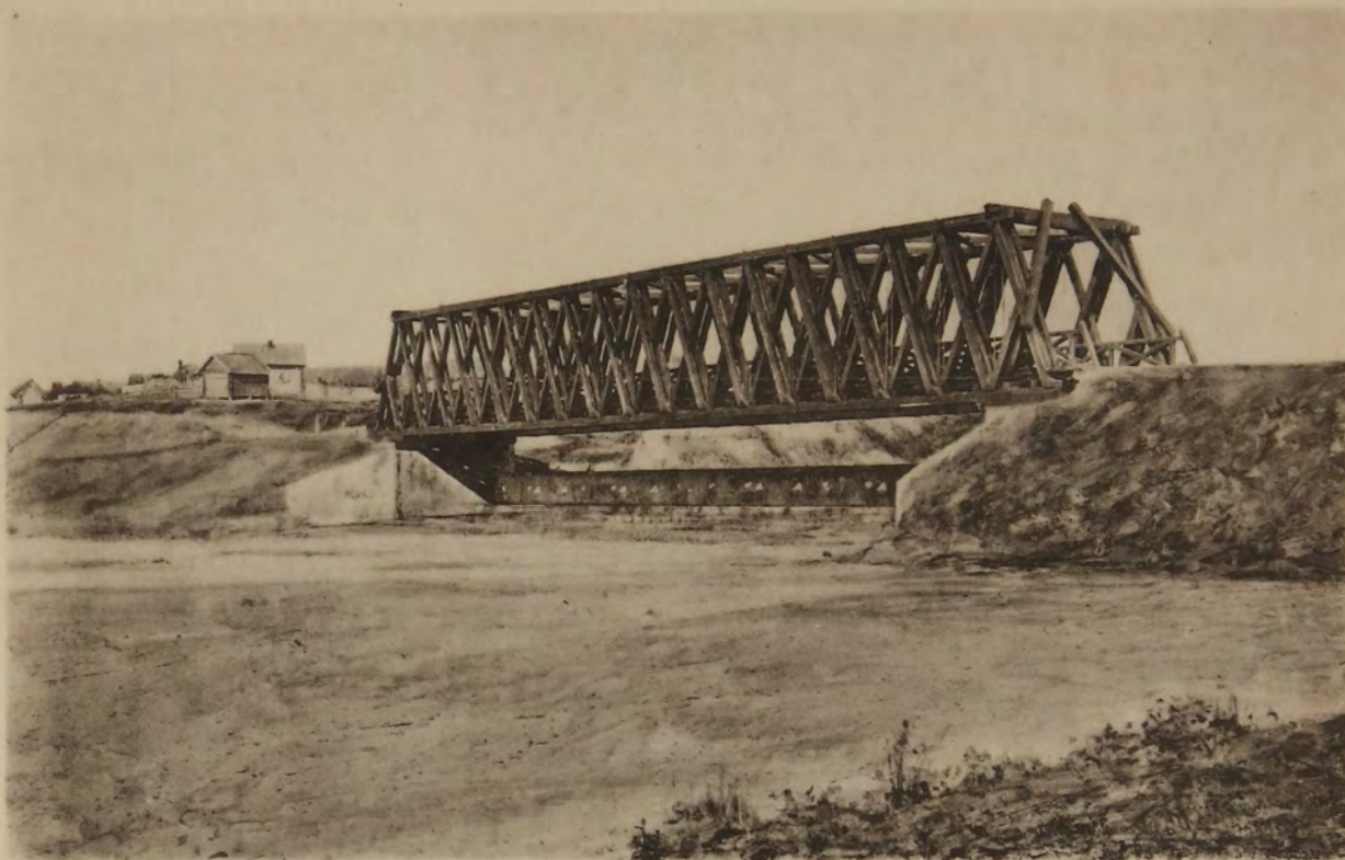
Бетонный водосливъ съ мостомъ „Гау“ на плотинѣ при д. Ср.-Татарскихъ-Юрткуляхъ, на 16 вер. оврага Раткула въ Спасскомъ у. Казанской губ.
