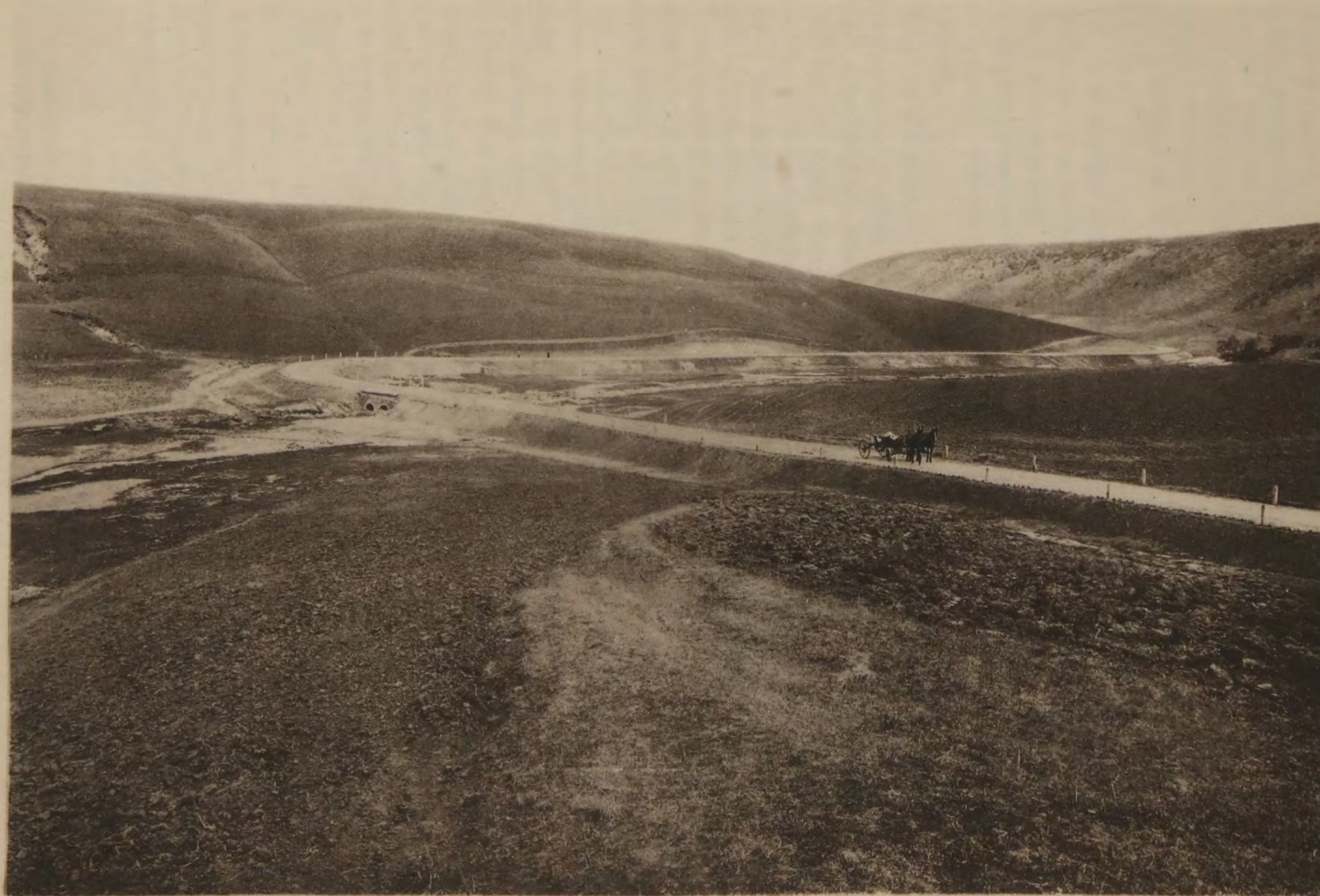
Дамба съ желѣзо-бетонной трубой черезъ „Медвѣжій оврагъ“ по тракту изъ дер. Верхней-Терешки въ д. Кармалей Средне-Терешанской вол. Хвалынскаго у. Саратовской губ.
