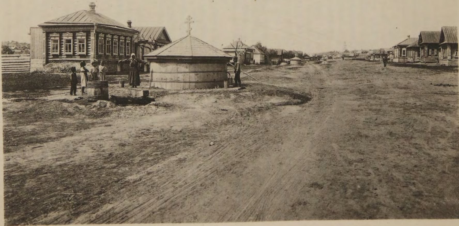
Водоразборные баки водопровода въ с. Павловкѣ Хвалынскаго у. Саратовской губ.
