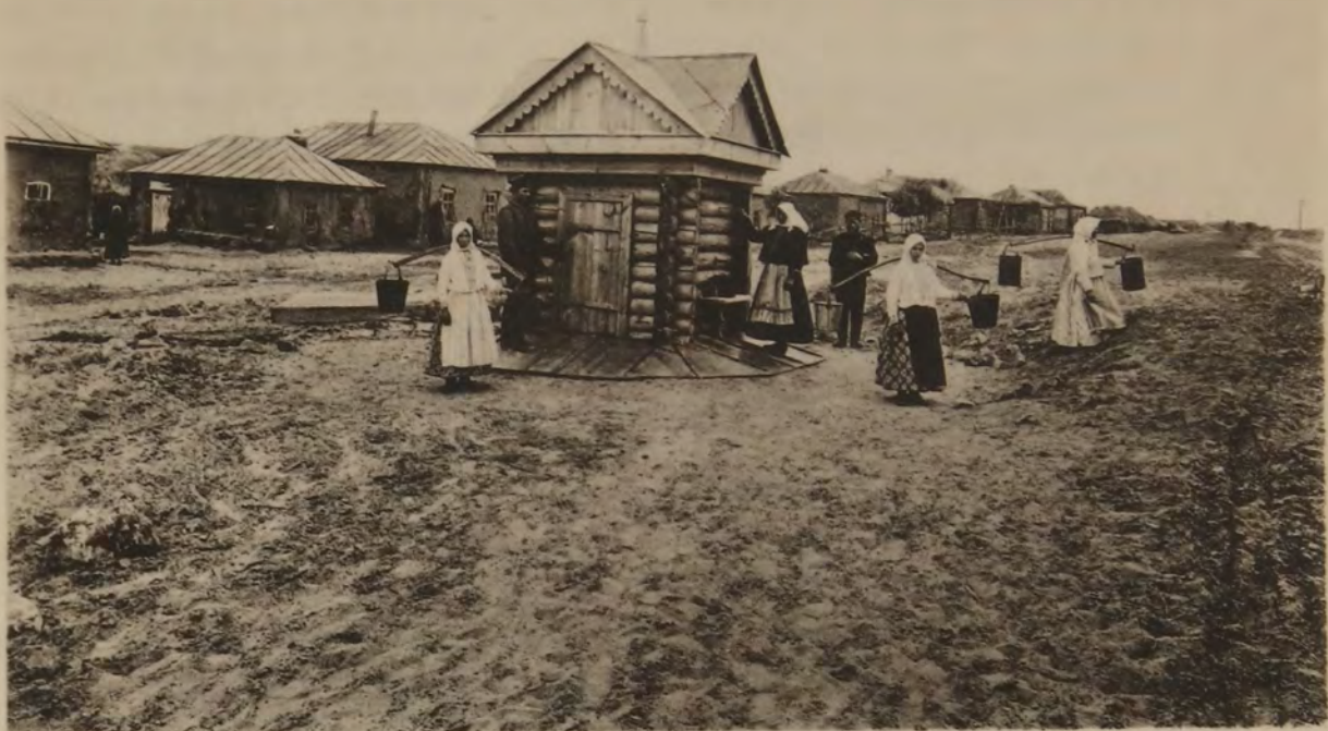
Водоразборная будка водопровода въ с. Новой-Студеновкѣ Бутурлинской вол. Сердобскаго у. Саратовской губ.
