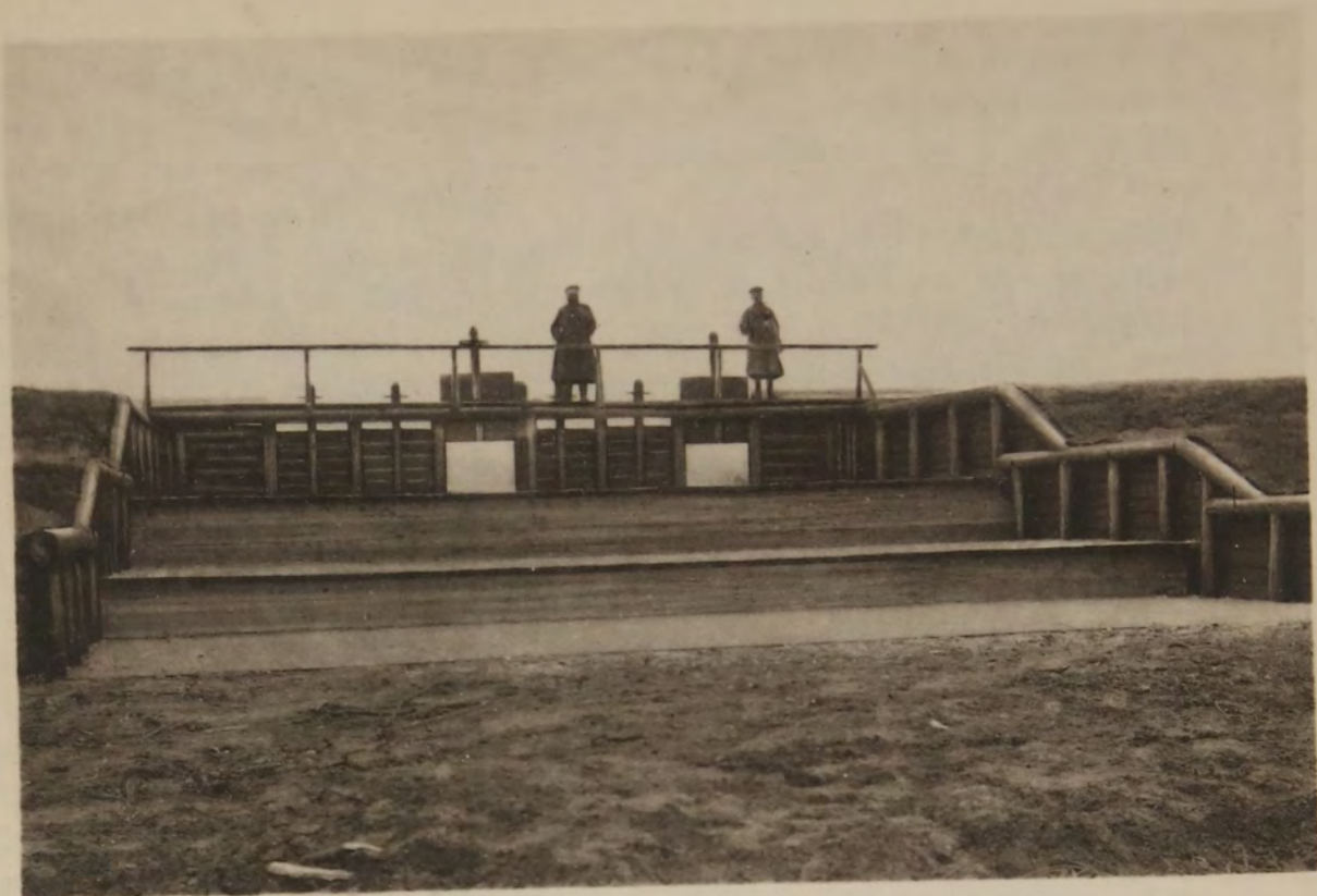
Водоспускъ на плотинѣ въ д. М.-Дюрягинѣ Каменной вол. Челябинскаго у. Оренбургской губ.
