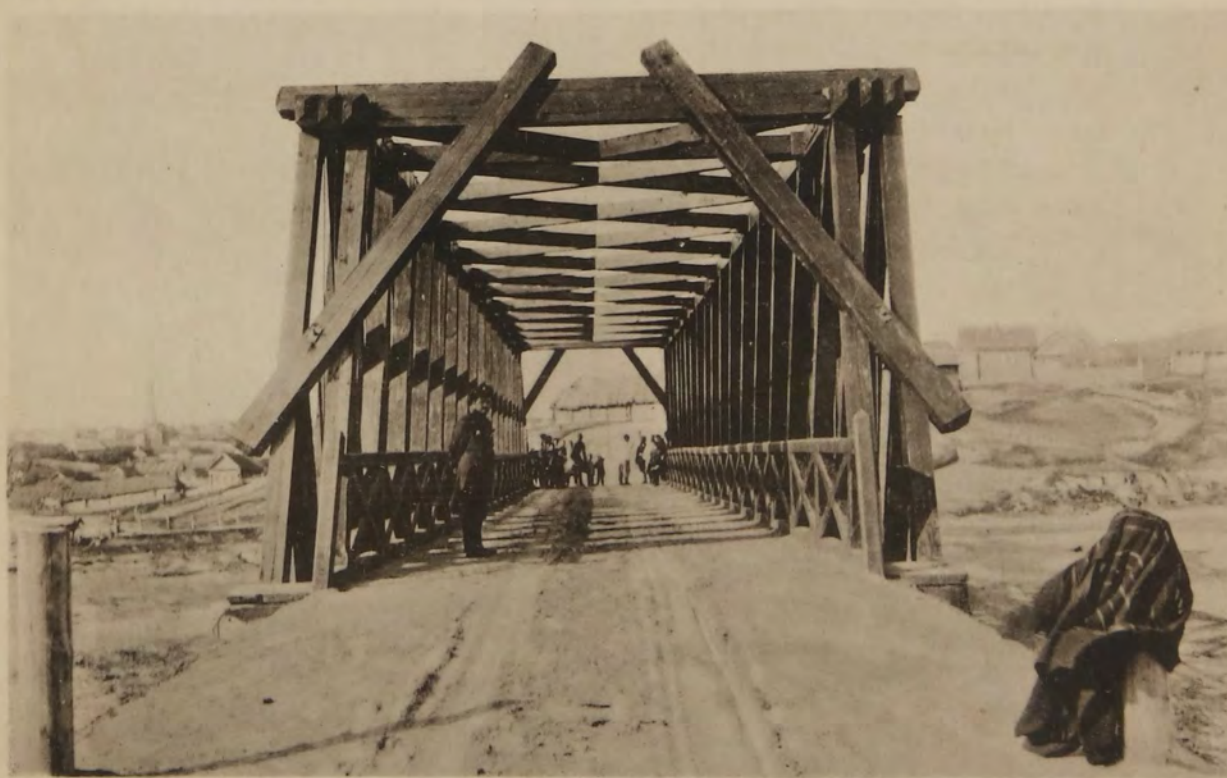
Мостъ „Гау“ на водосливѣ плотины при д. Среднихъ-Татарскихъ-Юрткуляхъ, на 16 верстѣ оврага Раткула въ Спасскомъ у. Казанской губ.
