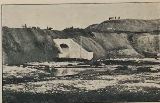
Каменная труба р. Сосновки.
