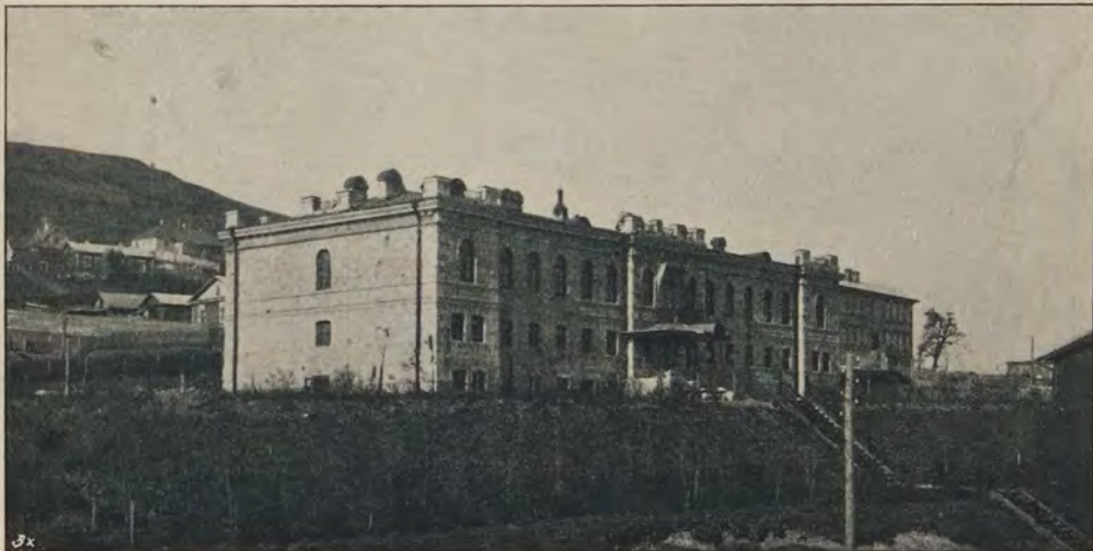
Г. Хабаровскъ. Зданіе управленія Уссурійской желѣзной дороги.
