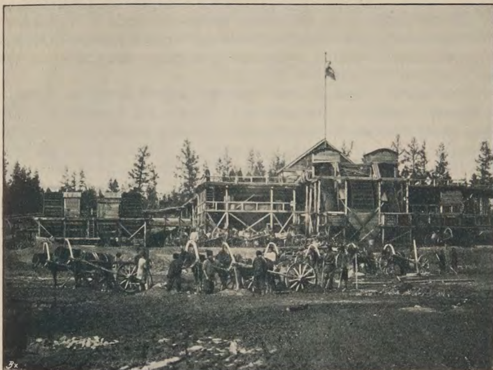
Золотопромывательная двухъ-башенная машина въ Южно-Енисейскомъ округѣ. Пріискъ г-на Черемныхъ.
