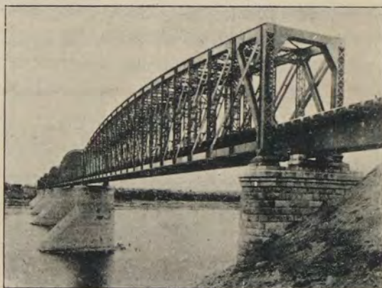
Мостъ черезъ р. Томь.
