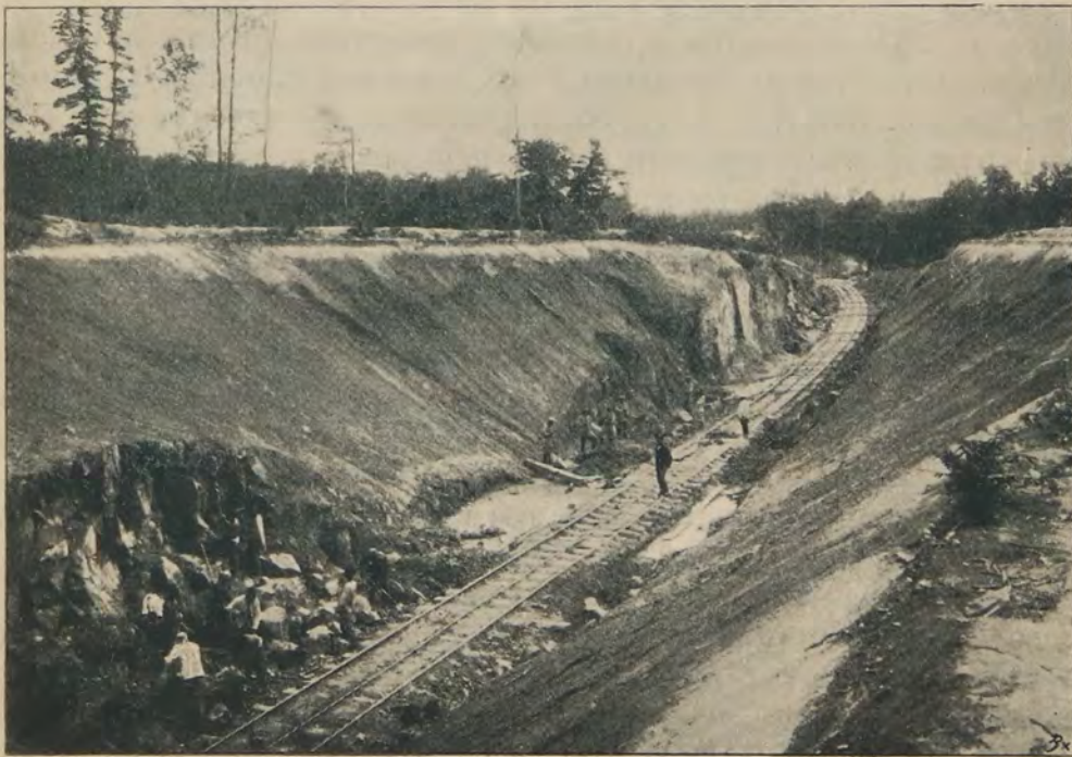
Рис. 25. Перевальъ желѣзной дороги черезъ хребетъ Нюрце (фот. Мацкевича).
