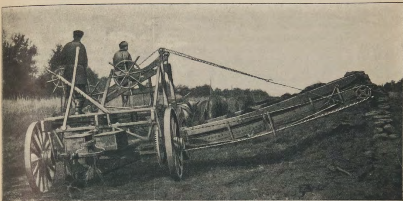
Земляныя работы машинами „New-era“.
