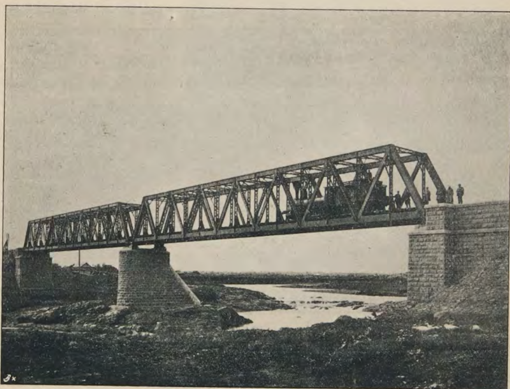
Мостъ черезъ р. Яю.
