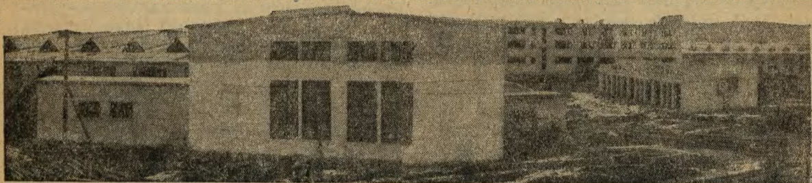
В Нижнем-Новгороде строится мощный станкостроительный завод, который будет выпускать ежегодно 3.000 фрезерных станков. Пуск завода состоится в январе 1932 г. На снимке: вид главного механического корпуса этого завода. («Союзфото»).
