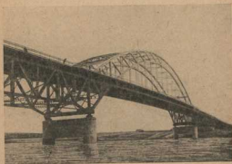
Рис. 4. Мост через Химкинское водохранилище на Ленинградском шоссе
