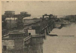
Рис. 2. Волжская бетонная плотина. Вид со стороны нижнего бьефа
