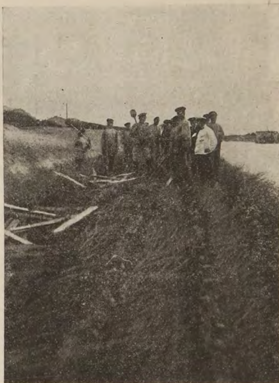
Фиг. 8. Фашинная кладка тяжелого типа по голландскому способу. Прибивка канатовъ кольями передъ загрузкой глиной (работы 1914 г.).
