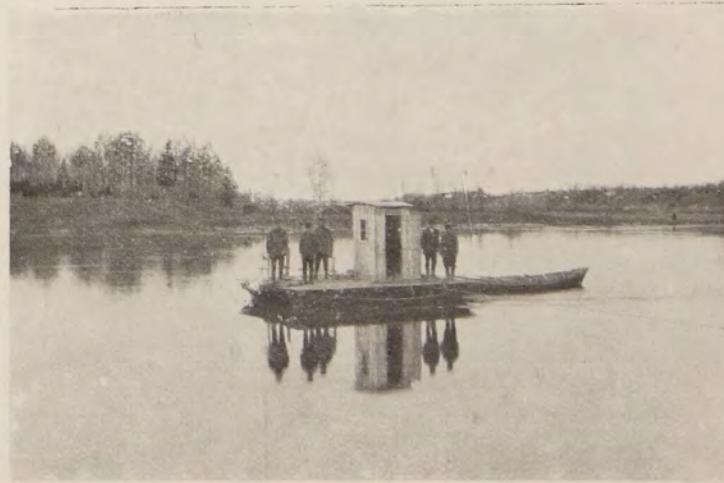
Главный рабочій профиль во время половодія: помость установленъ для наблюденія.
