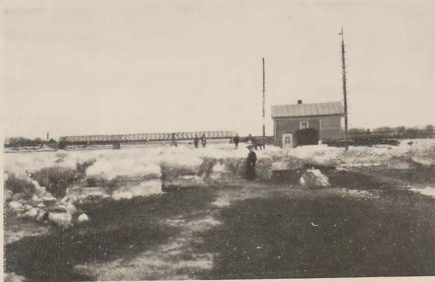
Общій видъ станціи, расположенной на лѣвомъ берегу рѣки Волги въ 250 саж. ниже желѣзнодорожнаго моста Николаевской ж. д. Снимокъ сдѣланъ по спадѣ воды при весеннемъ ледоходѣ.
