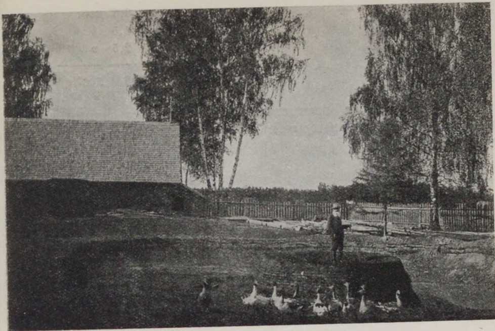
Земляныя работы по устройству пруда въ хозяйствѣ Іогана Цирка.
