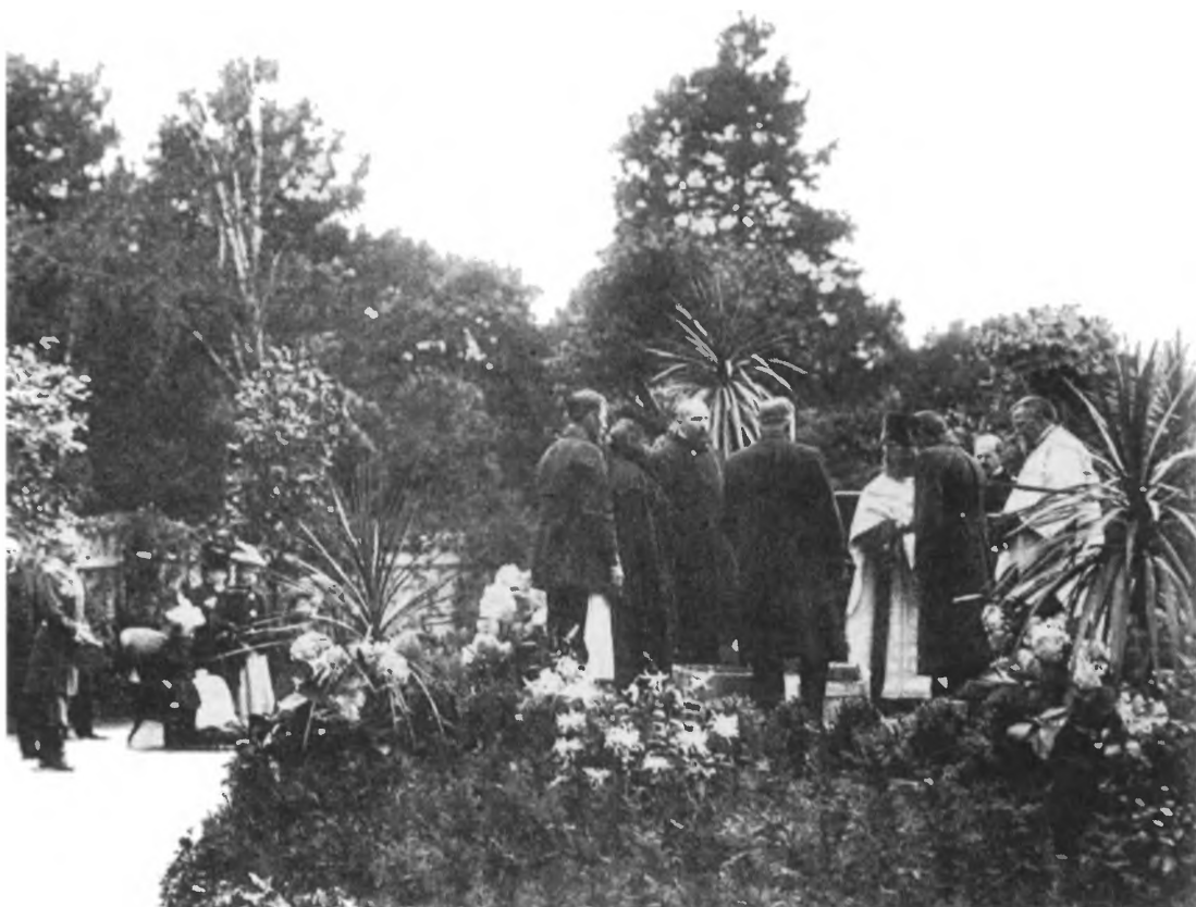
П. А. Столыпин 12 августа 1907 года на закладке памятника погибшим 12 августа 1906 года при взрыве его министерской дачи на Аптекарском острове
