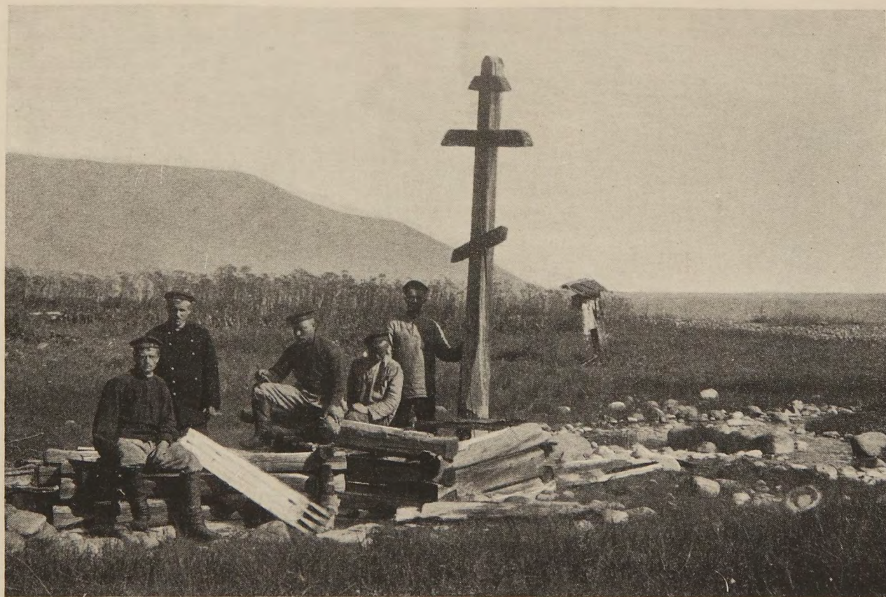
Горячій источникъ на мысѣ Котельниковскомъ (темпер. воды 45°).
