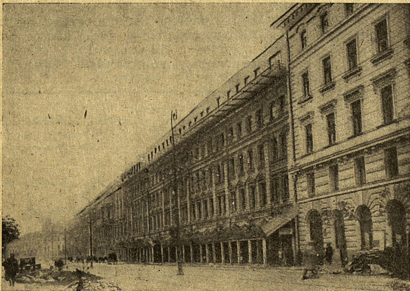
Неглинная, 17. Надстройка I этажа
