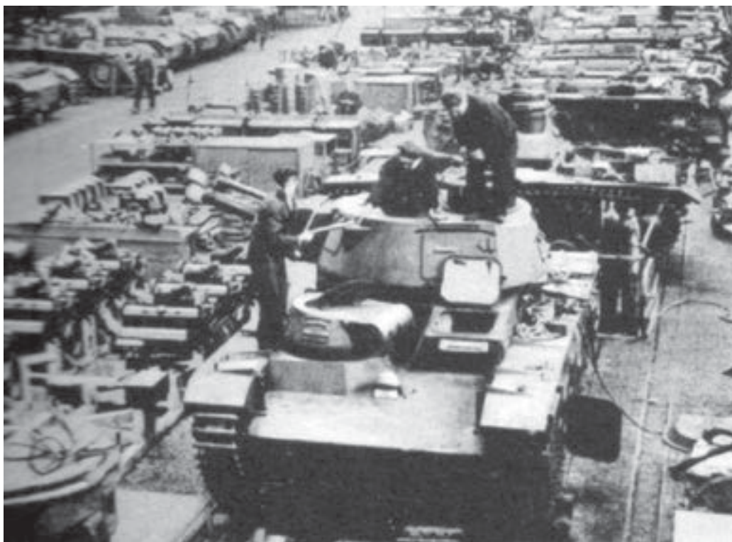
Сборка танков и штурмовых орудий на заводах Германии
