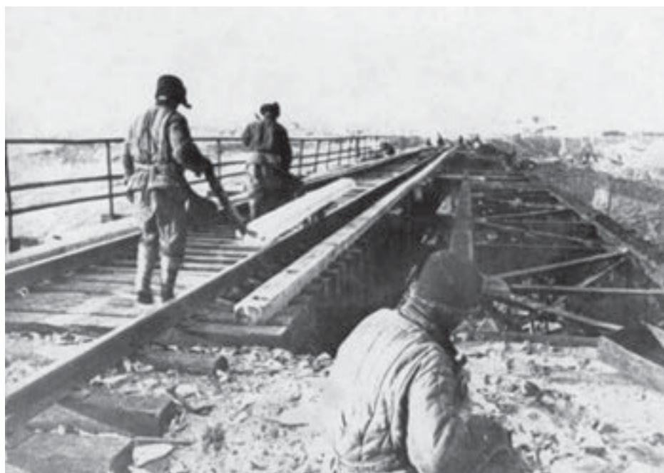
Восстановление железнодорожного моста
