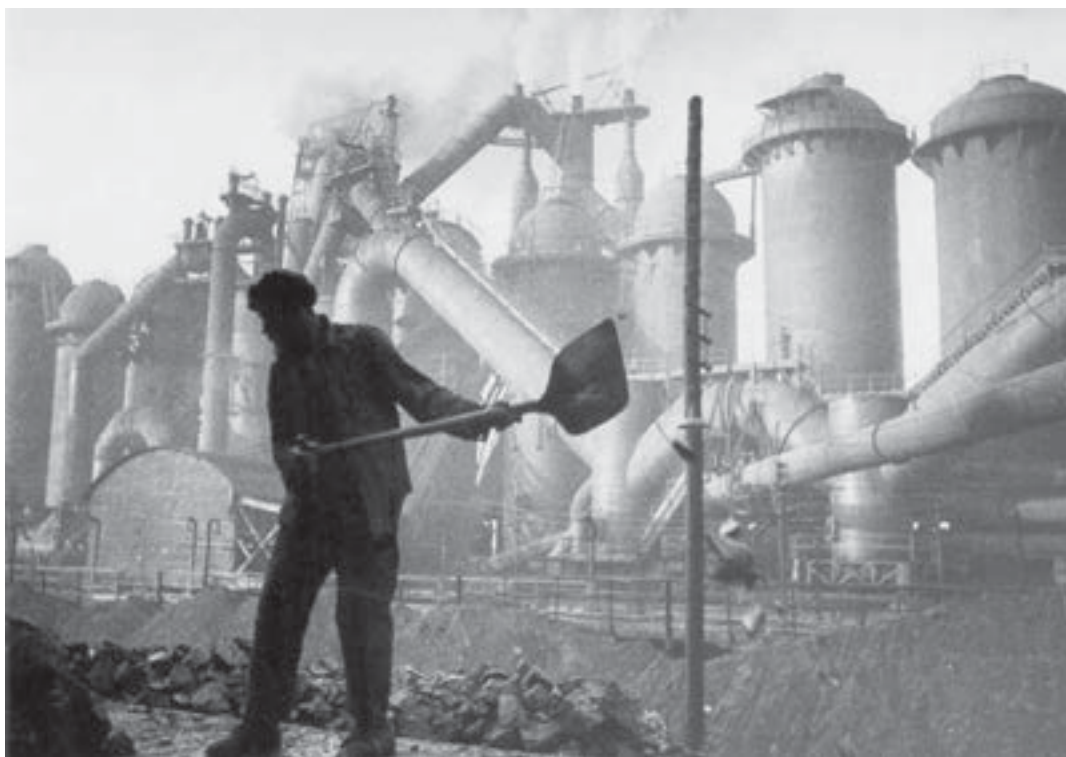
Строительство в Магнитогорске
