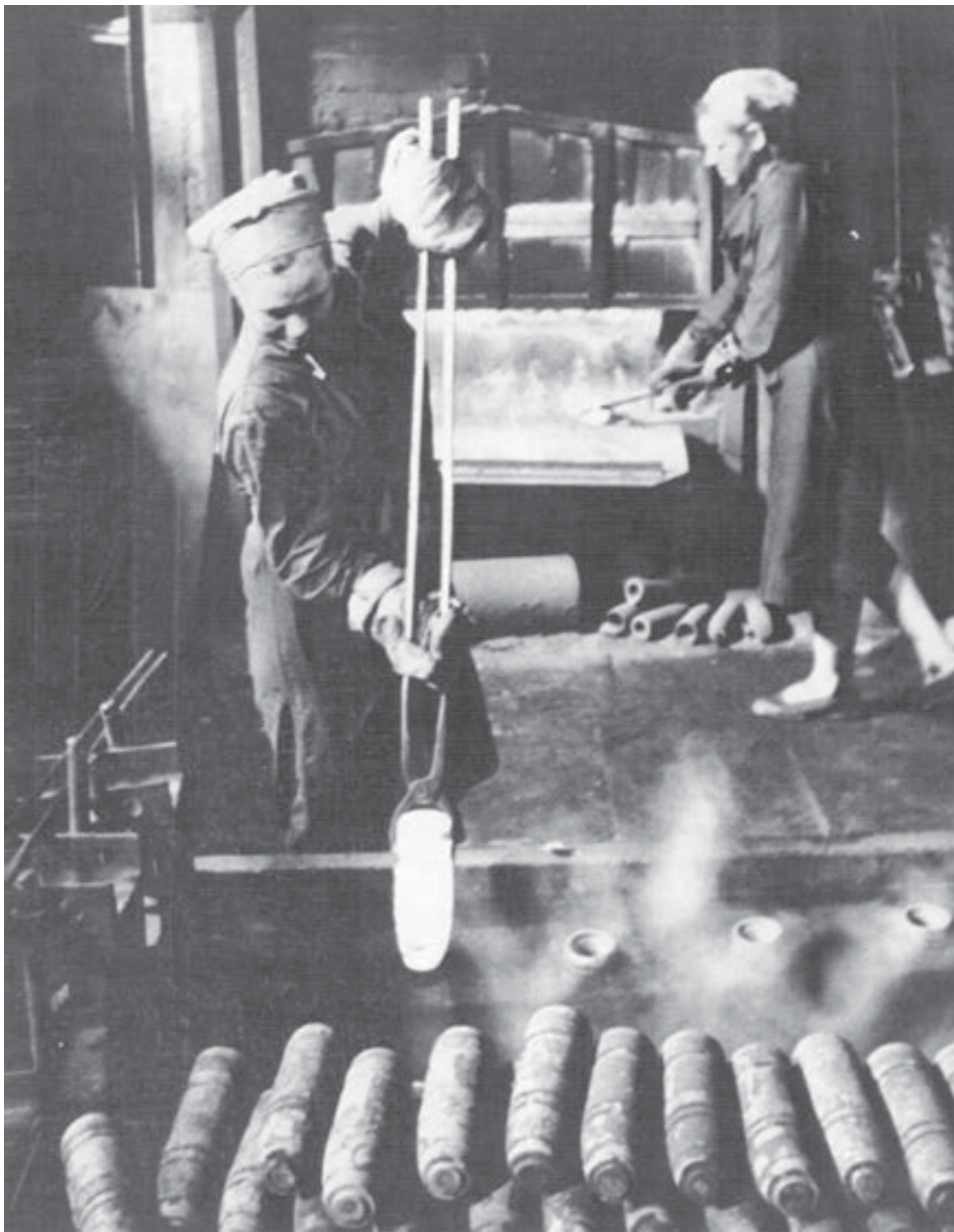
Женщины изготавливают корпуса артиллерийских снарядов
