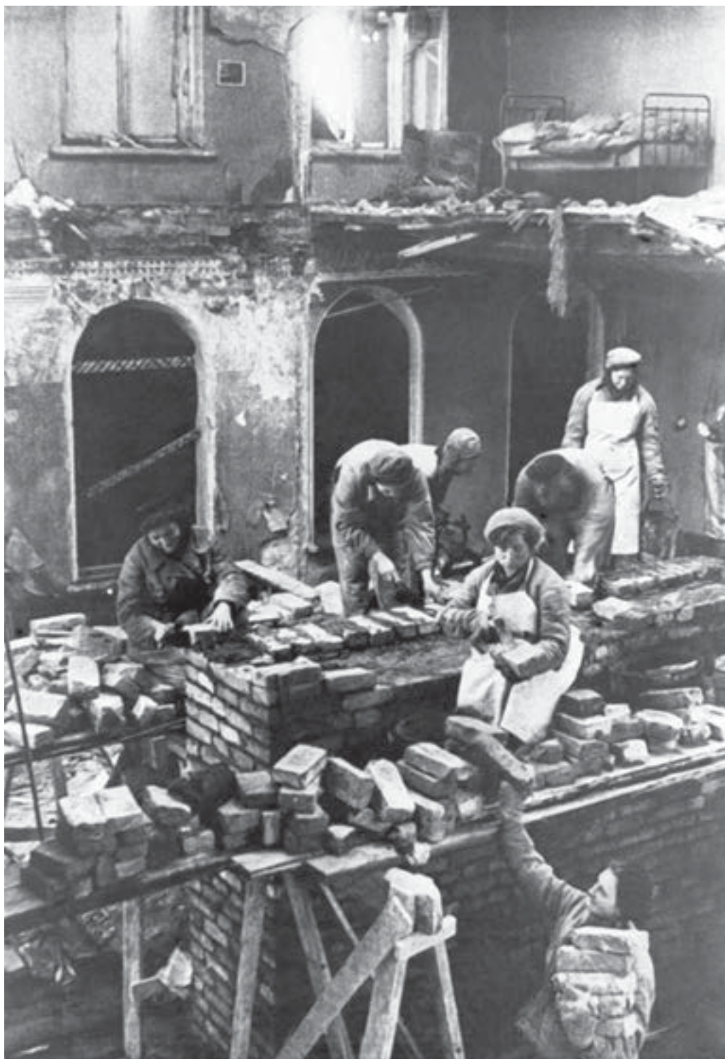
Восстановление разрушенного дома в Ленинграде
