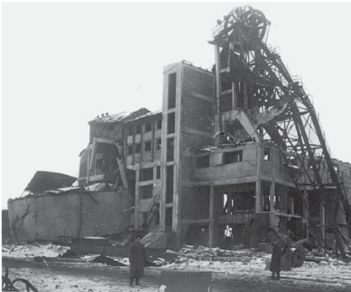
Разрушенные шахты Донбасса
