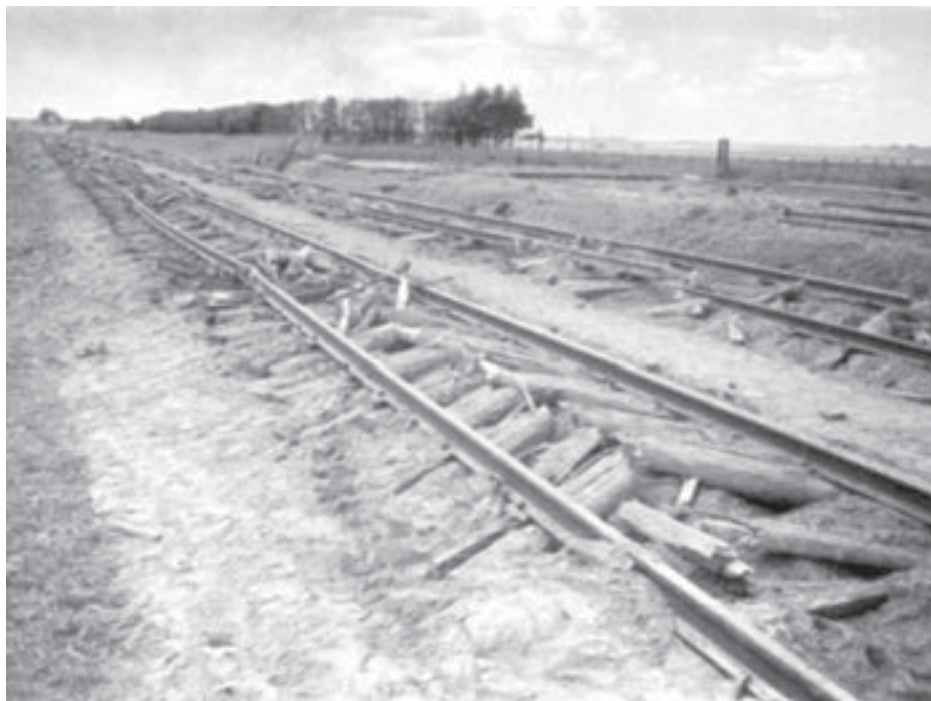
Железнодорожное полотно, разрушенное отступающими немецкими войсками
