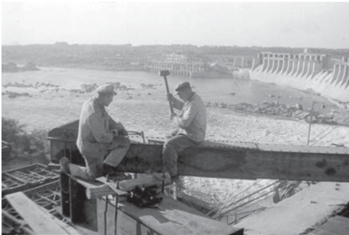
Работы по восстановлению Днепрогэса
